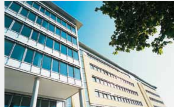
Solar Info Centre in Freiburg, Duitsland
