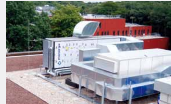
Duisburg, Duitsland: project Fraunhofer Instituut
